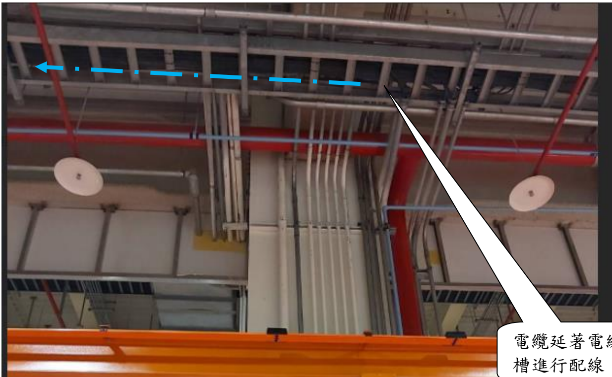
圖 5 電纜延著電線槽至空調子工場牆壁端
