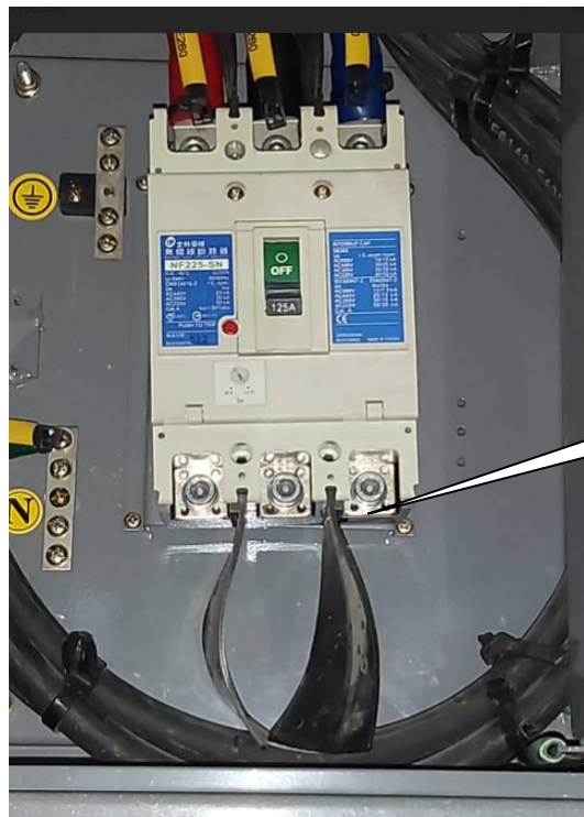
圖 3 EEA40 配電箱內部無熔絲斷路器(NFB)
