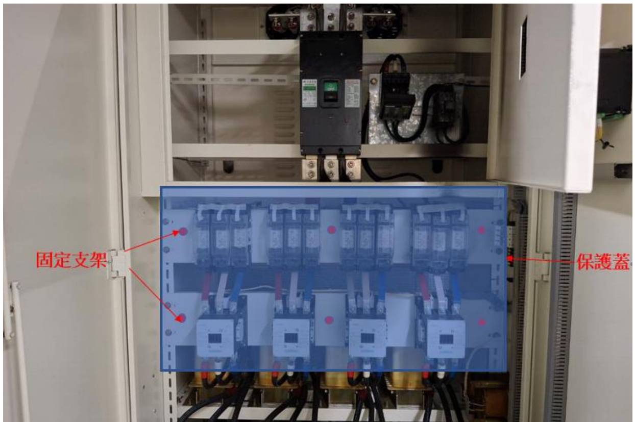
圖1 電容盤增加保護蓋(含固定支架)改善
