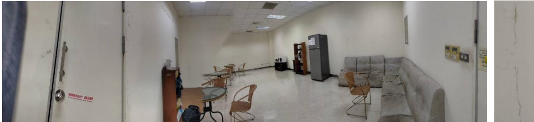
(室內牆高約 2.98 公尺 X 牆寬約 39.6 公尺=118M 2 )
