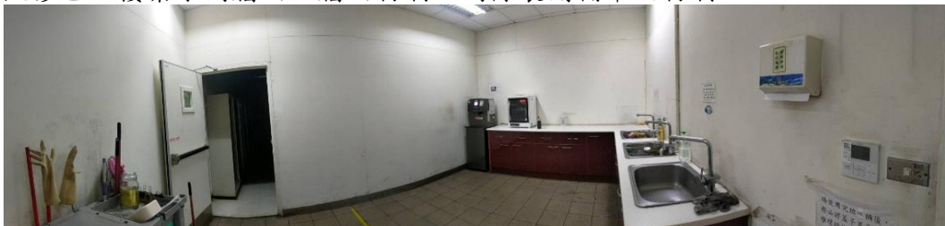
(室內牆高約 2.98 公尺 X 牆寬約 16.86 公尺=50M 2 )
