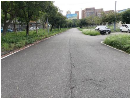
圖18：駐車區東側分隔線(17條線)
