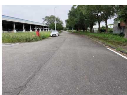
圖19：駐車區東側分隔線(18條線)
