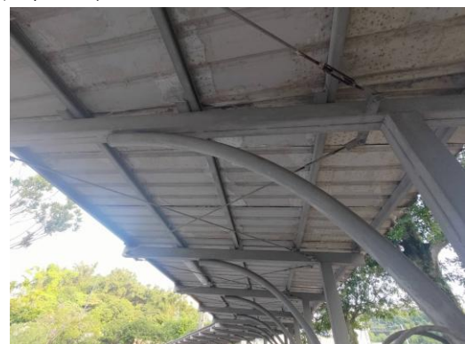
圖 4：遮雨棚下方浪板、主梁、橫梁。
