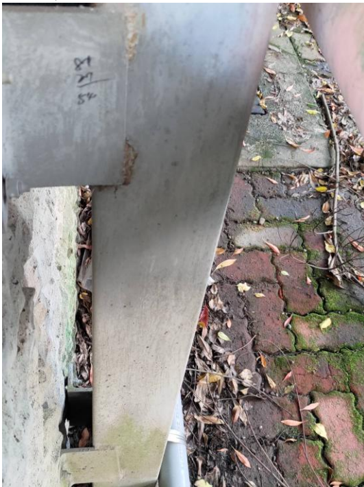
圖 8：遮雨棚下方立柱、及其固定件。
