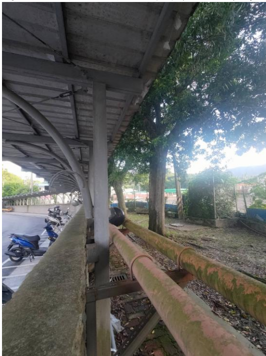
圖 7：遮雨棚立柱、斜撐管。
