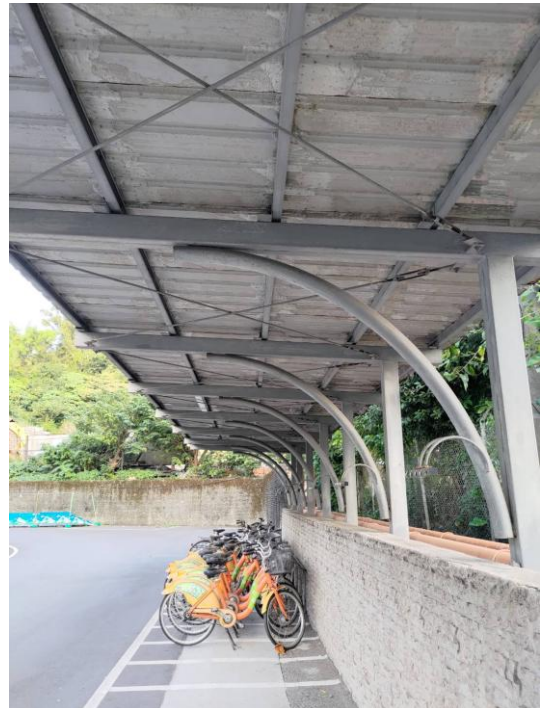
圖 2：機車遮雨棚 2(東側)。
