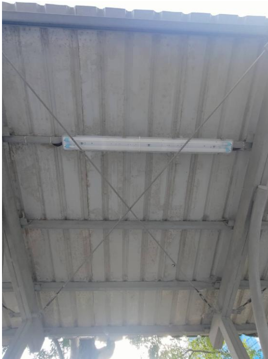
圖 5：遮雨棚下方浪板、拉桿及照明。 圖 6：遮雨棚下方浪板、鬆緊器。
