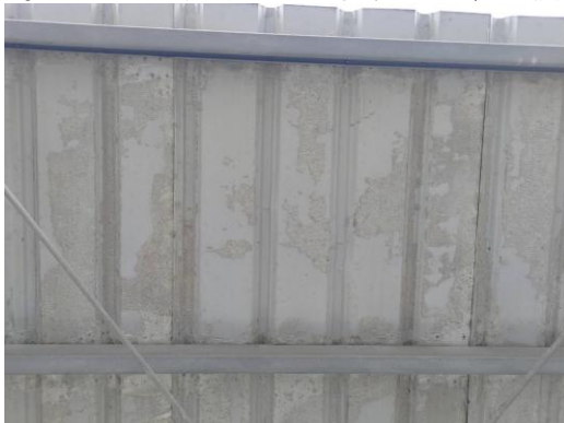
圖 3：遮雨棚浪板、橫梁。
