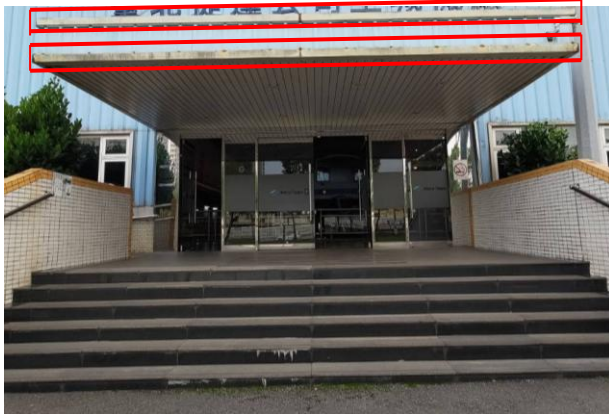
圖 2: 側面處除銹粉刷
