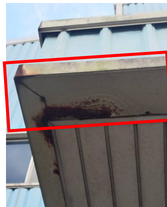
圖 3: 側面處除銹粉刷
