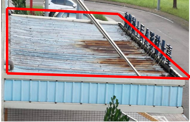
圖 1:頂部浪板更新（長寬約 6.5 公尺 X 4.0 公尺=26M 2 ）
