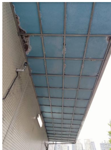
圖 5:頂部平板銹蝕狀況。
