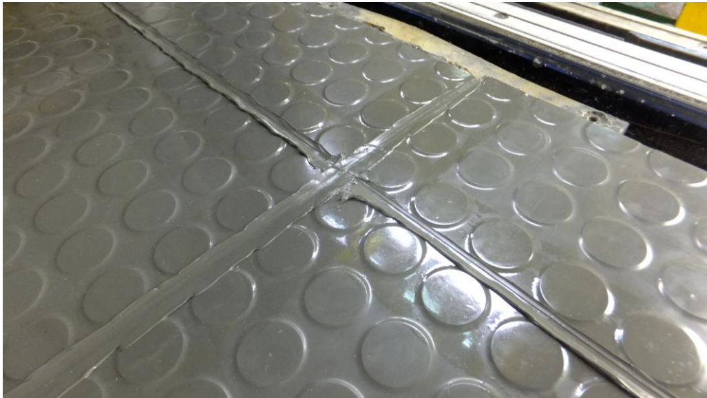
圖 11 將填縫劑注入溝縫中
