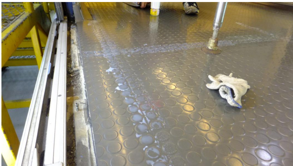
圖 9 在地板皮接合處塗抹水臘
