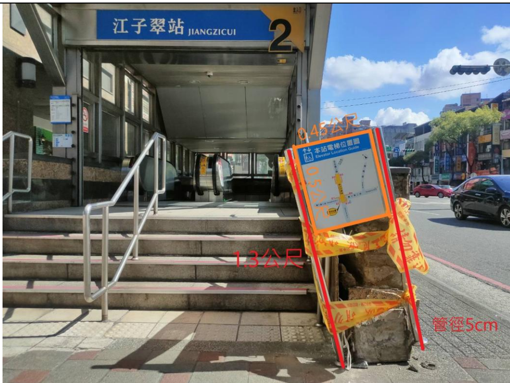
不鏽鋼告示牌板拆除及更換位置
