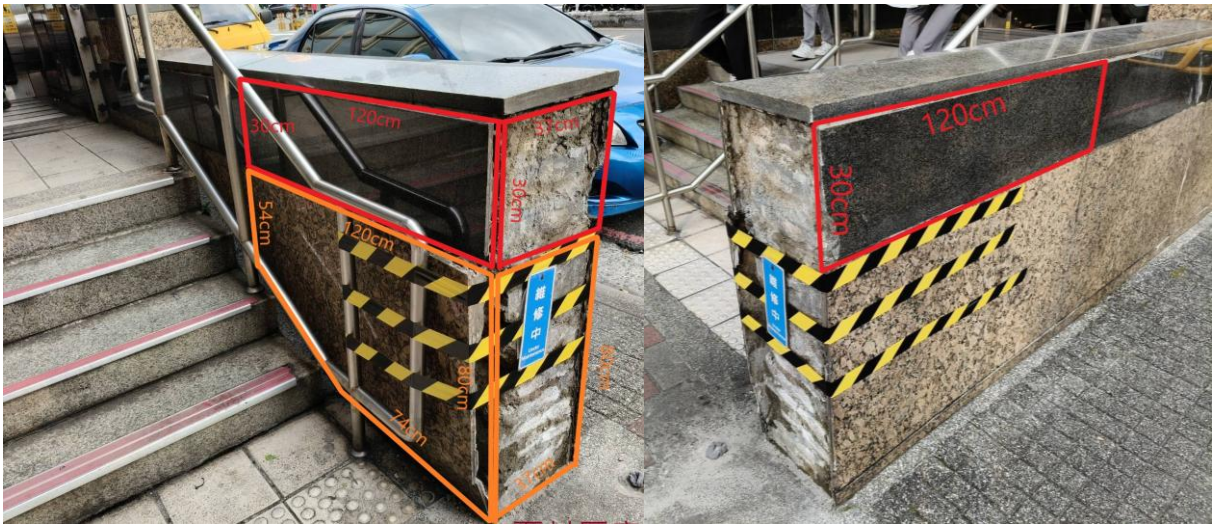
石材拆除及更換位置
